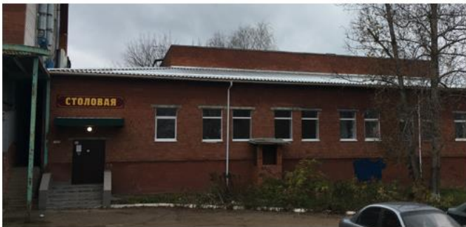
Входная зона вид после ремонта
