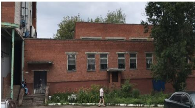
Входная зона вид до ремонта
